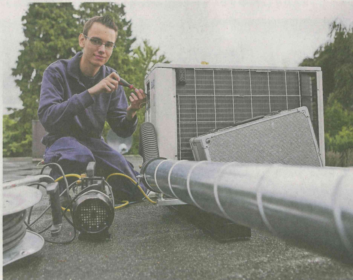
Sebastian Wensky schraubt an einem Gerät, für das fast alle bei hochsommerlichen Temperaturen dankbar sind: Er wartet als angehende Kältetechniker die Klimaanlage.
